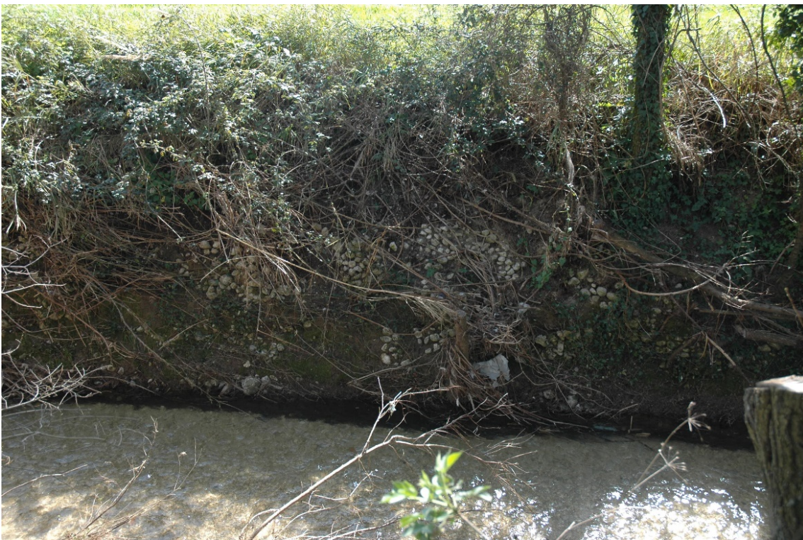
Figura 9: Muro in opera incerta sulla sponda sinistra del Torrente Galantina (2°-1° secolo a.C.).
