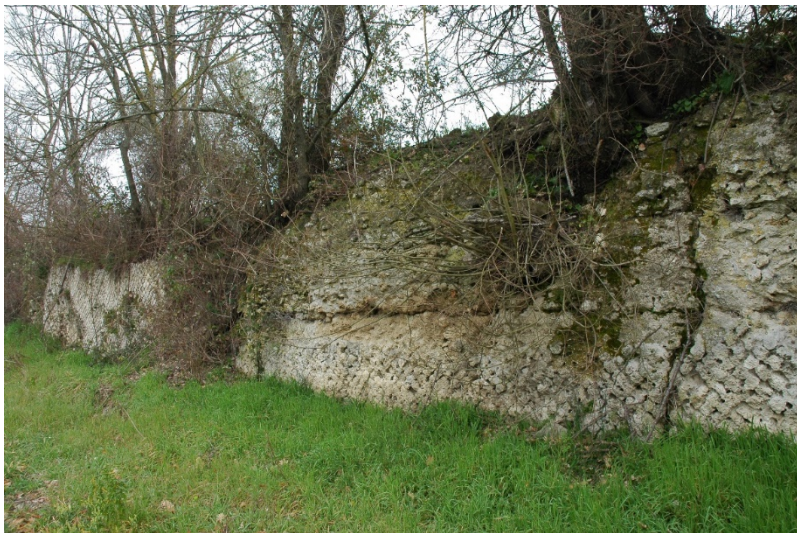
Figura 16: Muro in opera reticolata del terrazzamento superiore della villa romana del Castellaccio.
