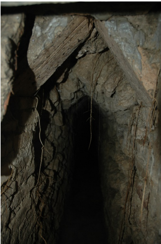
Figura 22: Condotto dell'acquedotto che serviva la villa romana di Formello, costruito con blocchetti di calcare.
